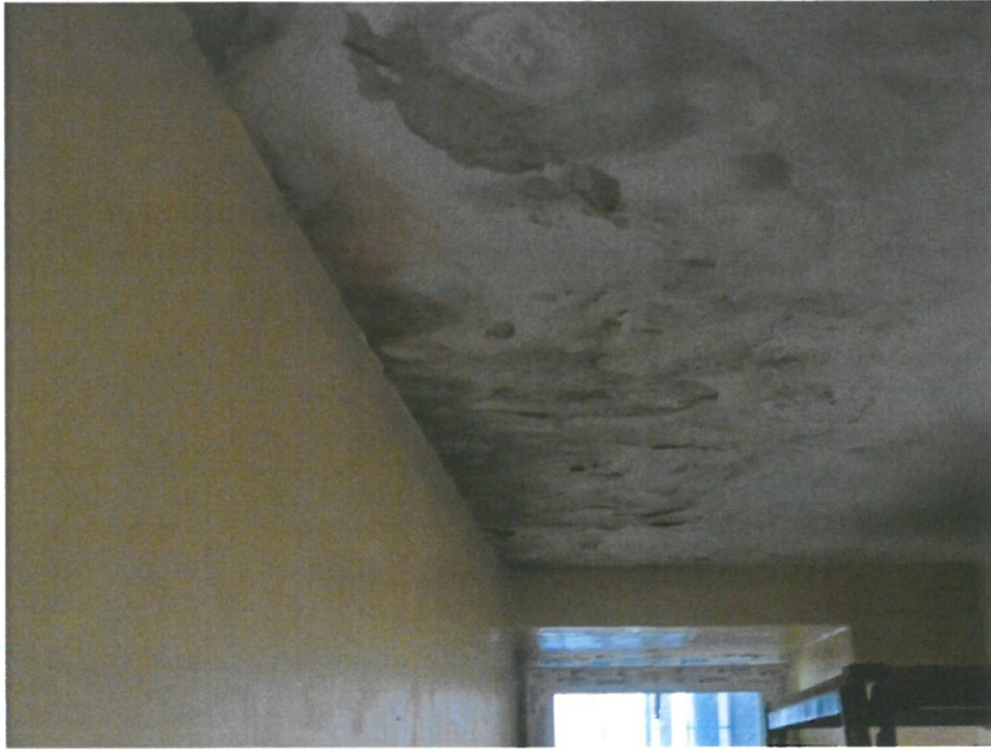
Rys. 4: Zawilgocenie stropu na połączeniu ze ścianą fundamentową
