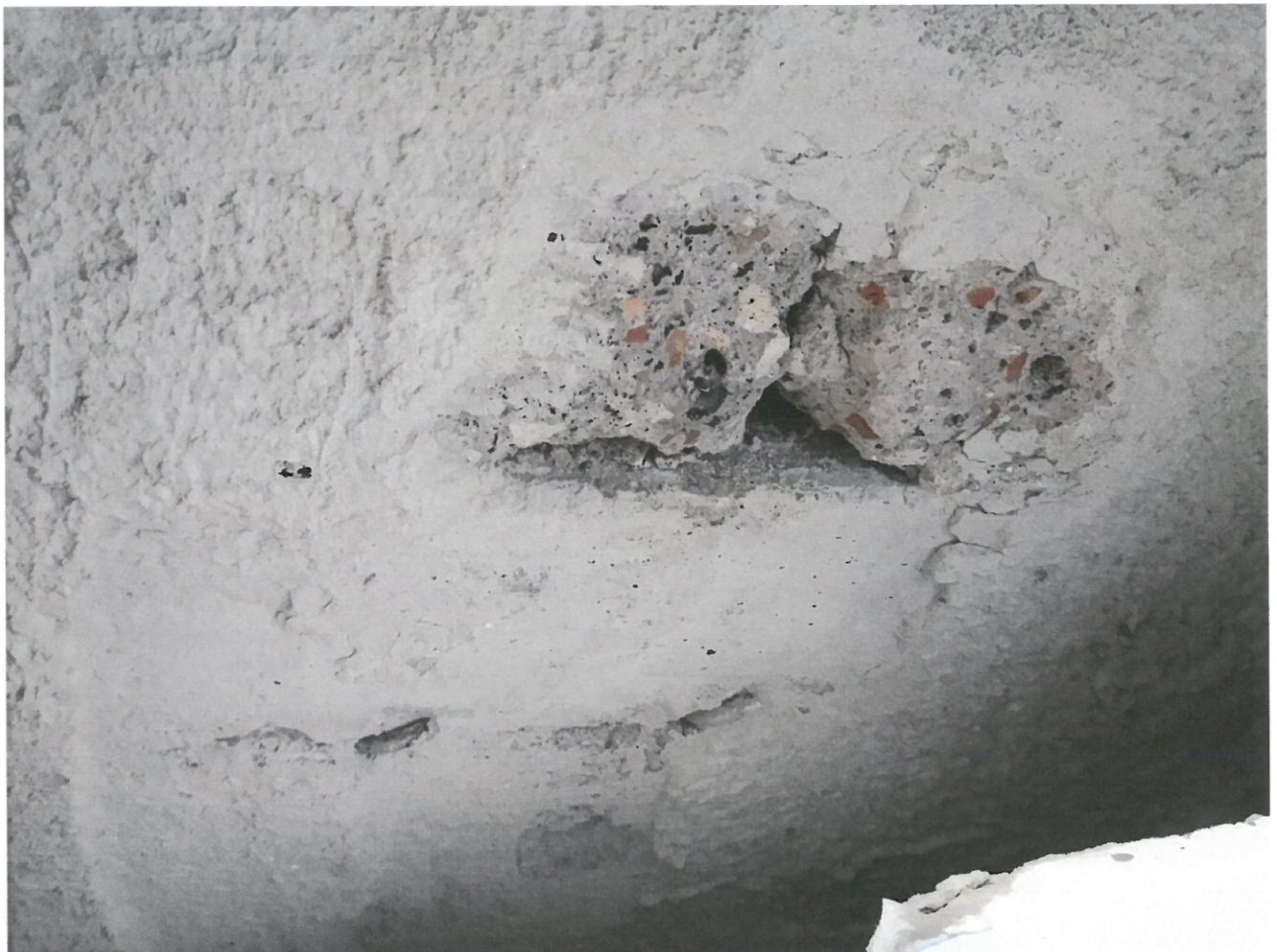
Rys. 5: Odkrywka stropu nad 2 piętrem – widoczna belka stropu DMS oraz pustaki żużłobetonowe
