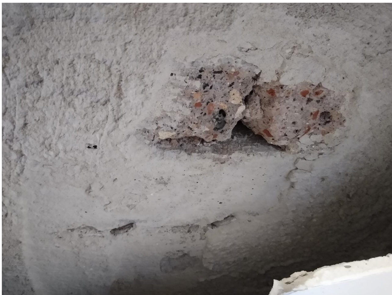
Rys. 5: Odkrywka stropu nad 2 piętrem – widoczna belka stropu DMS oraz pustaki żużlobetonowe
