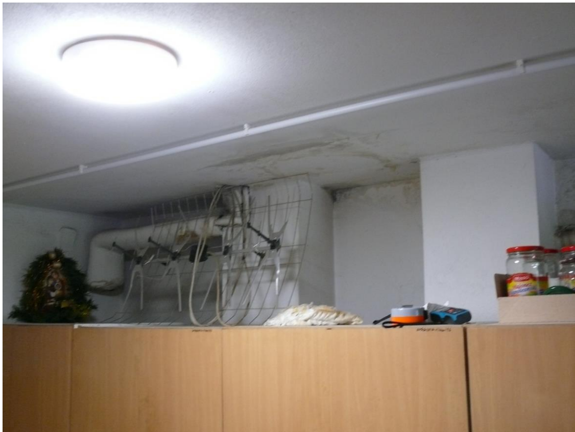
Rys. 2: Zawilgocenie w obrębie komina – strop nad piwnicą
