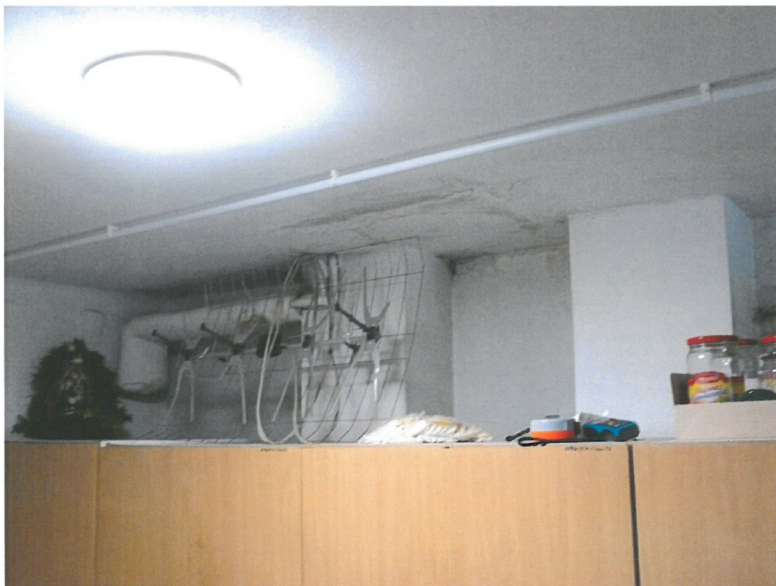
Rys. 2: Zawilgocenie w obrębie komina – strop nad piwnicą
