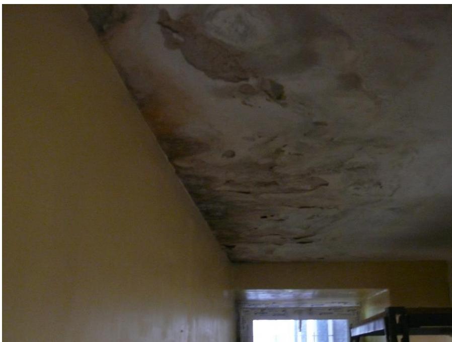
Rys. 4: Zawilgocenie stropu na połączeniu ze ścianą fundamentową
